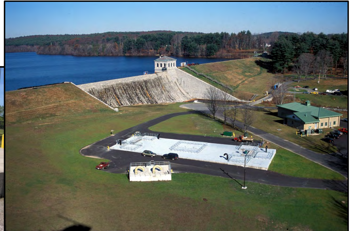
MWWST Shaft E
